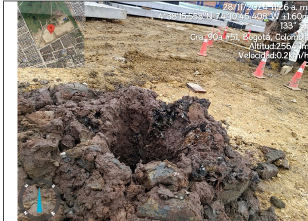
Fotografía 7. Material extraído en prebarrenado
