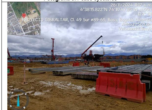
Fotografía 5. Pilotes prefabricados
