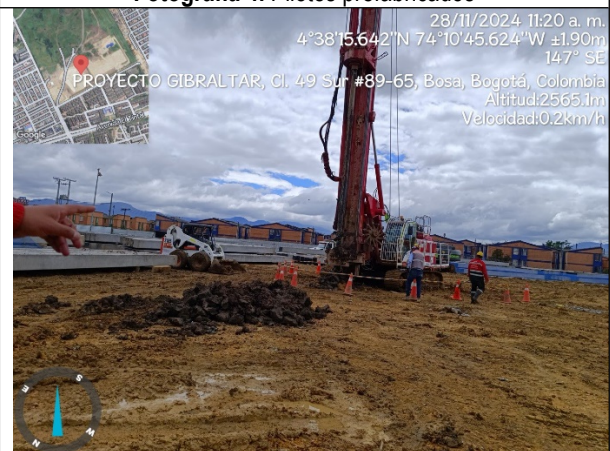
Fotografía 6. Prebarrenado
