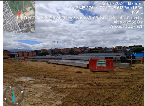
Fotografía 4. Pilotes prefabricados
